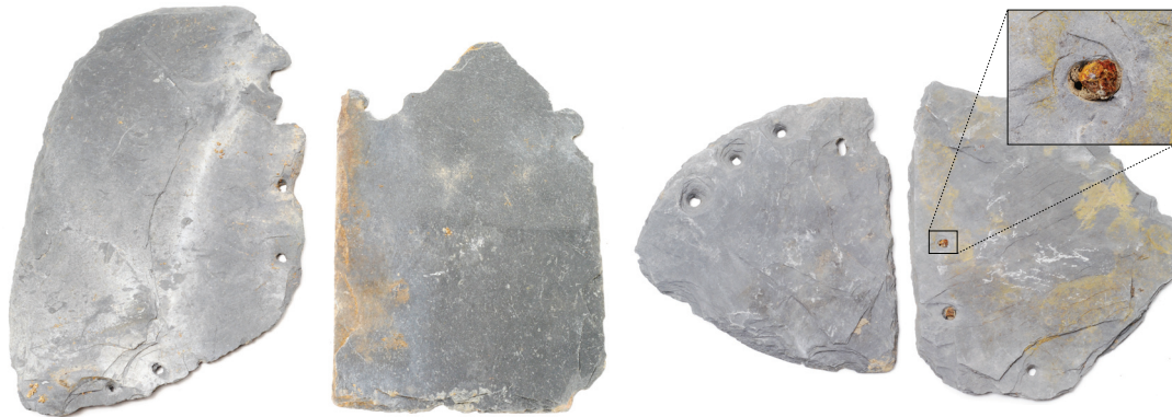
Afb. x: Verschillende dakleien (linker twee: V242, rechter twee: V43). Een restant van het ijzerdraad waarmee de leien bevestigd werden is in één exemplaar nog in de gaatje in de lei aanwezig. Afbeelding niet op schaal; de rechthoekige is 16,5 cm breed.
