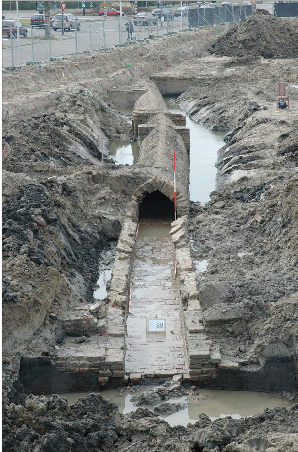
Afb. x: Foto van het in 2009 opgegraven deel van de watergang (S20). De knik die de watergang maakt ter hoogte van de plek waar de pandhofgang op de watergang gefundeerd was, is duidelijk zichtbaar. Foto richting het zuiden.
