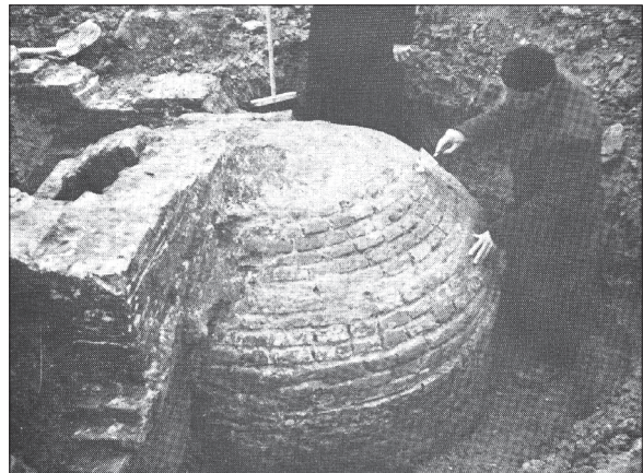
Afb. x: Bij de opgraving van het kartuizerklooster te Delft werd een beerput met intacte koepel aangetroffen. Links op de foto zijn de muren te zien van de gang die naar de stortkoker leidde. Uit: Gumbert 1975, afb. 12.
