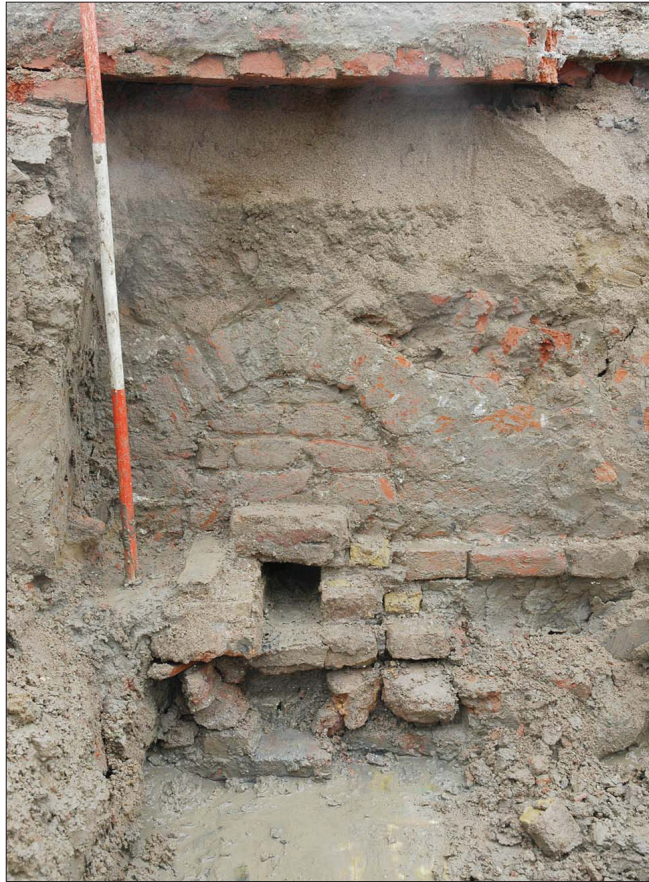
Afb. x: Waar de goot de fundering van de muur van de pandhofgang snijdt is te zien dat er een voorganger aanwezig is geweest. Het muurwerk boven de zandige laag is recent. Foto richting het zuiden.
